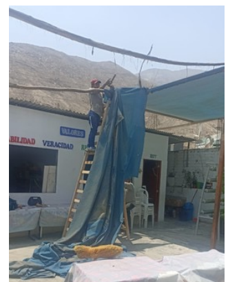
Montage des Netzes
