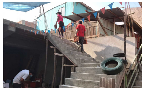
Die Bewohner helfen mit bei der Erweiterung der Schule
