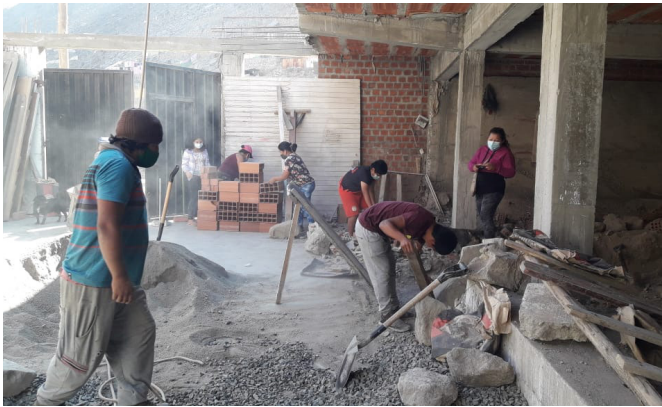
Der Bau der neuen Küche ist in vollem Gang.
