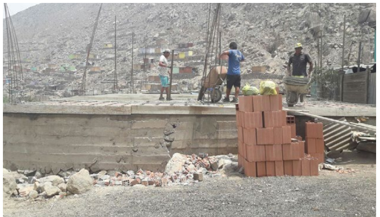
Die neue Decke für das Schulgebäude wird erstellt.
